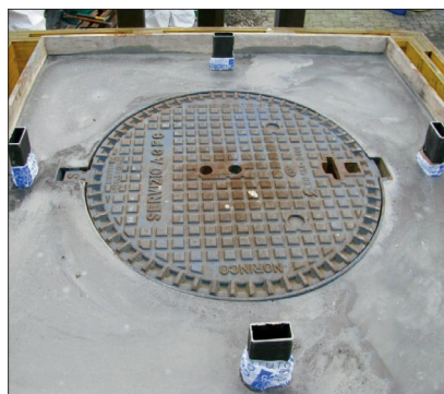
c) posizionamento del coperchio
