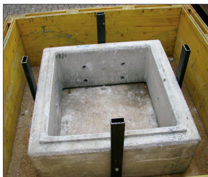
a) parte apicale del pozzetto nel cassero di contenimento
