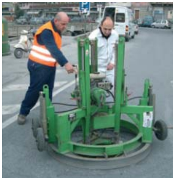
Rimozione telaio con estrattore
