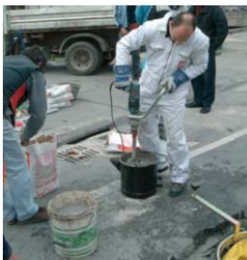
Preparazione malta da colare con l'utilizzo del miscelatore
