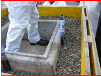
Riempimento con ghiaia tra il terminale in cls e il cassero
