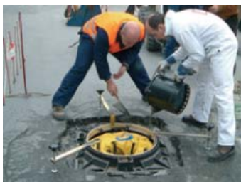
Colata malta con armatura gonfiabile
