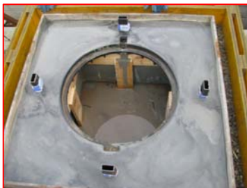
Termine delle operazioni di gettata della malta fresca
