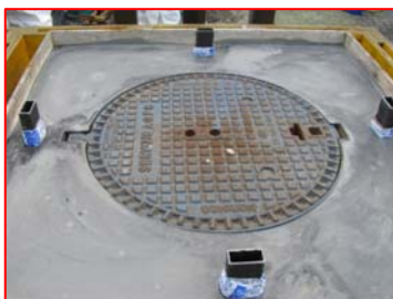
Termine delle operazioni di messa in quota
