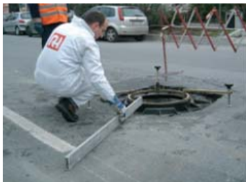
Misurazione quota del chiusino con livellatore
