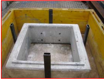
Elemento terminale in cls del pozzetto stradale inserito nel cassero
