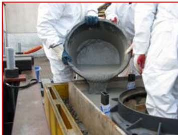
Versamento della malta fresca all'interno del telaio di contenimento
