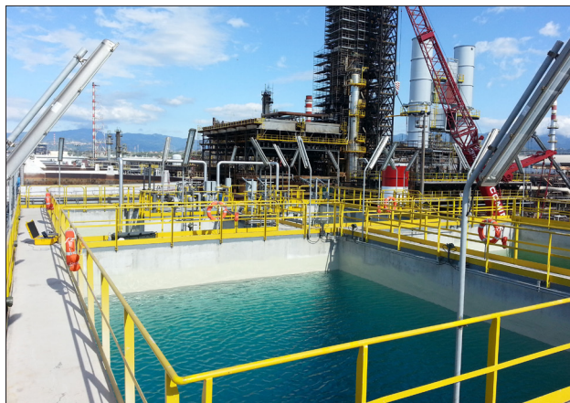
Il metodo DLG è particolarmente indicato per le prove su vasche in calcestruzzo
