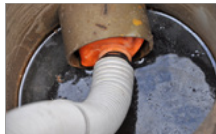
La tubazione sarà automaticamente sigillata non appena il fumo passa attraverso il tubo
