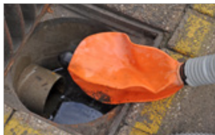
Fissaggio dello SmokeStopper alla fine del tubo di alimentazione.
