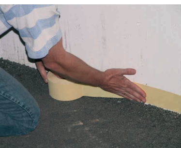
Pulire e rivestire con nastro adesivo le superfici adiacenti
