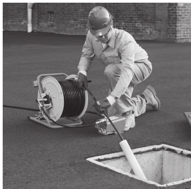
Figura 10 – Estensione dell'apertura della condotta al punto operativo
