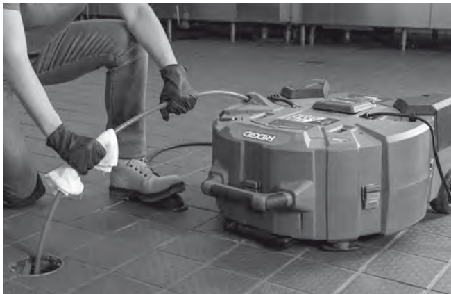
Figura 15 – Asciugatura del cavo durante il recupero
